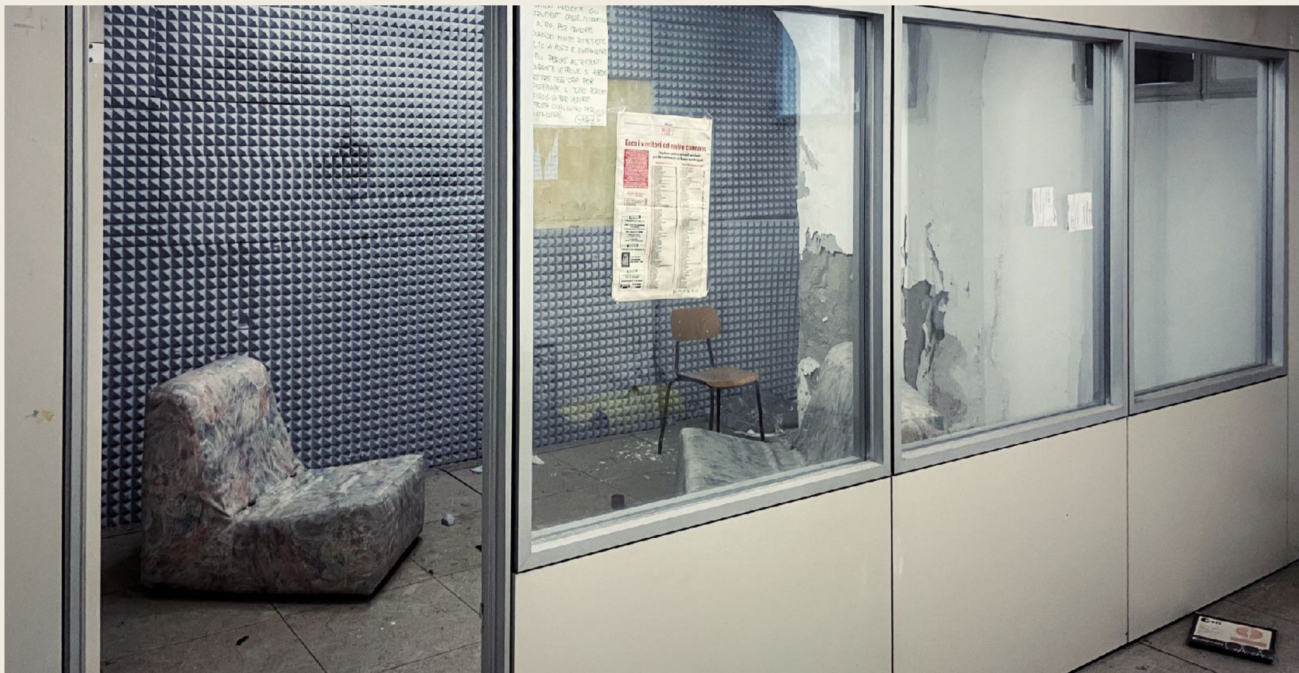
Particolare dei resti della stazione radio che alloggiava nel seminterrato ovest
